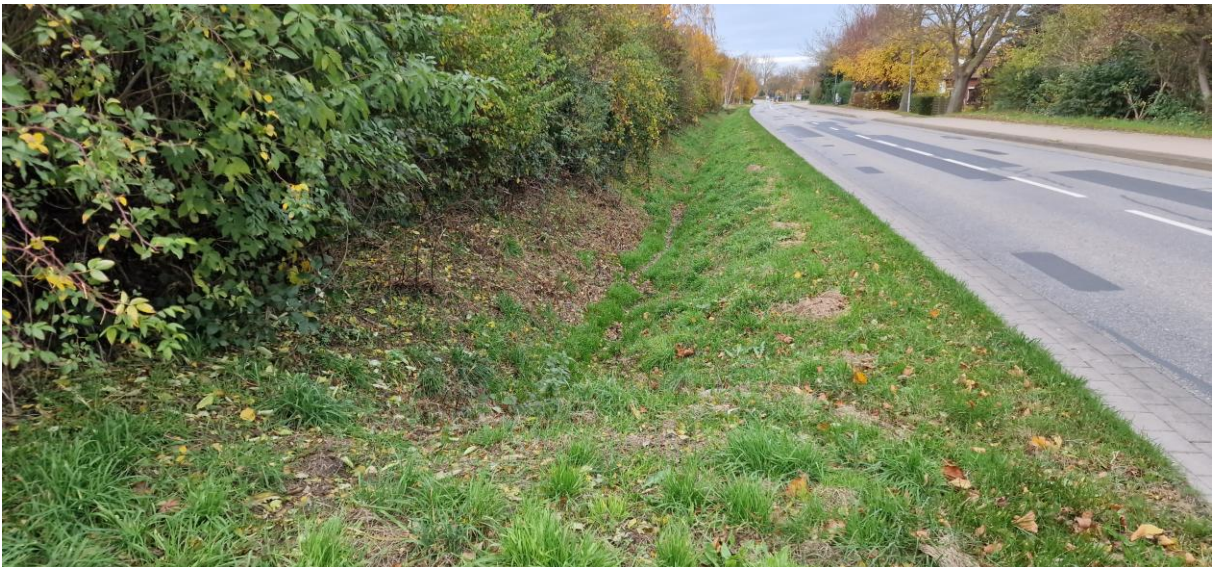
Abbildung 8: Straßenbegleitender Graben östlich des Geltungsbereichs.
