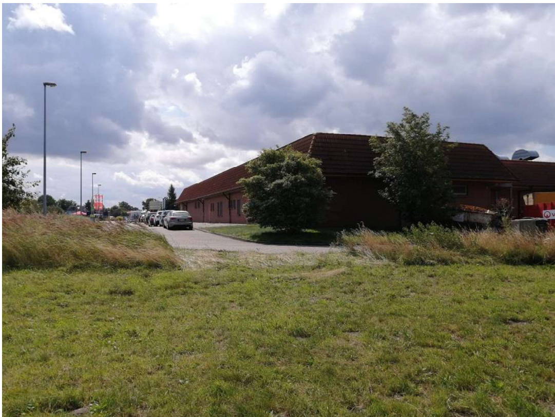
Abb.6: Nord- und Ostseite des Einkaufszentrums, Blickrichtung: Nord
