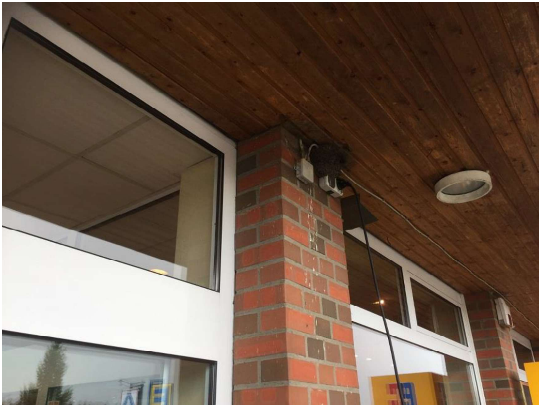
Abb.2: Südfassade Einkaufszentrum, Mehlschwalbennest
